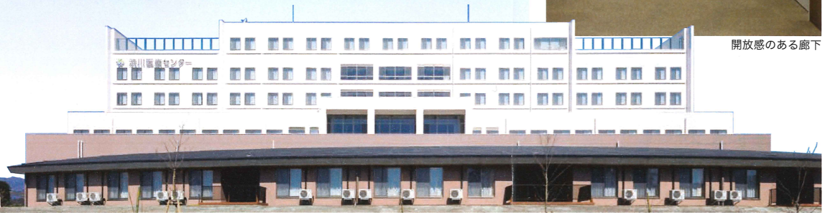
緩和ケア病棟全景
