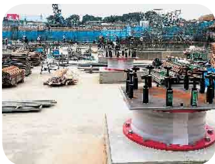
大小合わせ100個以上の免震ゴムが規則的に配置されています。
